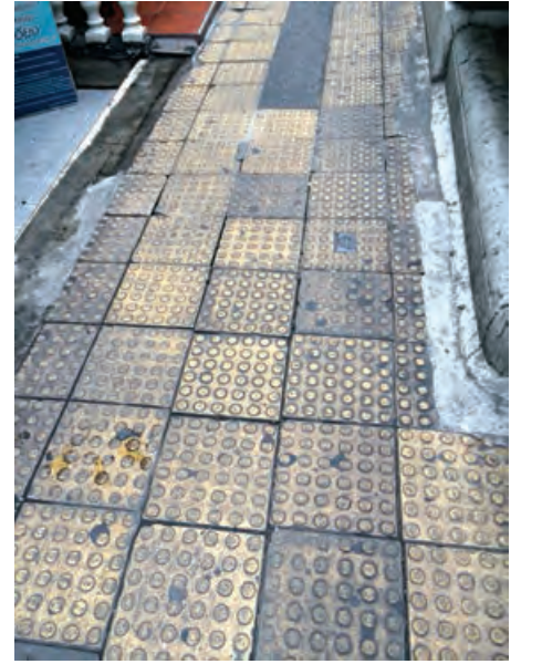
Resim 2. Görme engellileri konutlarından metroya erişebilmeleri için yönlendirecek zemin kaplamaları deforme edilmiş, Bangkok. Fig. 2. Flooring designed to guide the visual impaired to the underground trains has become warped, Bangkok.
