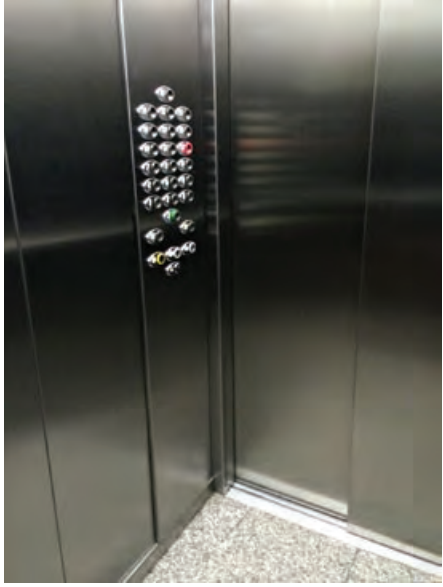
Resim 6. Bütün engelli kategorilerinin kullanabileceği asansör örneği (erişilebilir düğme yükseklikleri, Braille alfabeli düğmeler, otomatik açılır kapı). Fig. 6. A lift that can be used by people with all types of disabilities (buttons at accessible heights, marked in Brail, and door that opens automatically).
