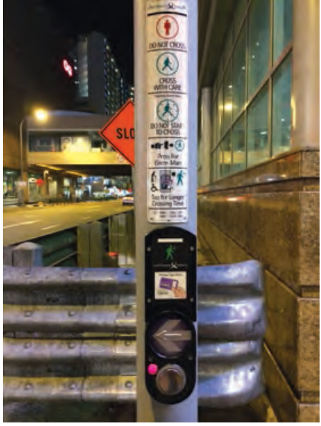
Resim 4. Engelliler ve yaşlıların kent içi erişilebilirliğini sağlamak için trafik ışığı süre kontrol paneli, Singapur. Fig. 4. Traffic light period control panel for the aid of the disabled and elderly, Singapore.
