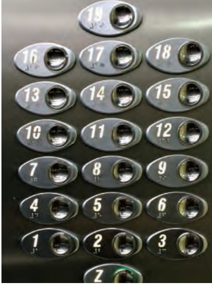
Resim 6. Bütün engelli kategorilerinin kullanabileceği asansör örneği (erişilebilir düğme yükseklikleri, Braille alfabeli düğmeler, otomatik açılır kapı). Fig. 6. A lift that can be used by people with all types of disabilities (buttons at accessible heights, marked in Brail, and door that opens automatically).
