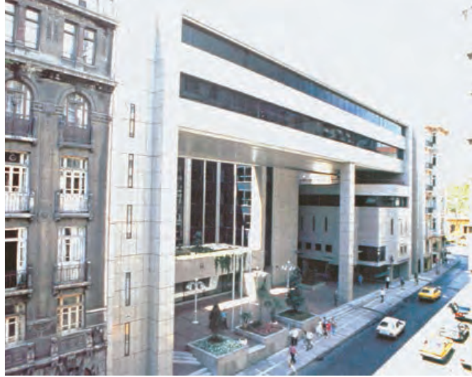
Milli Reasürans Binası
