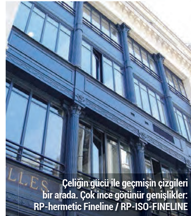
Çelik cephelerle işlevsel şeffaflık: Yatay ve düşeyde ince hatlar. Yüksek taşıma değerleri.
