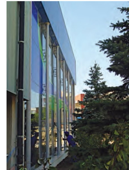
Birgi-Mefar İlaç Fabrikası ek binası ön cephe taşıyıcı sistem görünüşü. View of the loadbearing system for the front façade of the annex at the Mefar Pharmaceutical Manufacturing Plant in Birgi.
