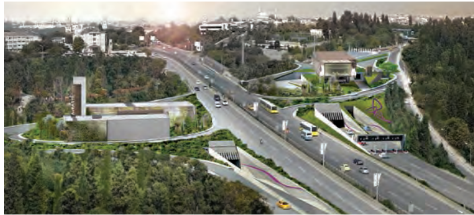
1. Avrupa Giriş Kapısı 2. Avrupa Havalandırma İstasyon Binası 3. Tünel/TBM 4. Operasyon ve Kontrol Binası 5. Asya Havalandırma Binası
