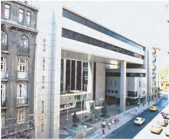
Milli Reasürans Binası
