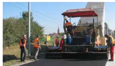
Apply asphalt layer
